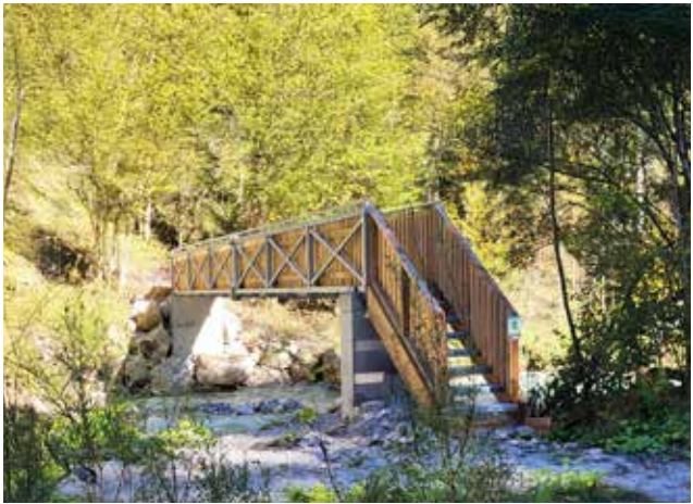
Fertiggestellte Holzbrücke über den Buchauer Bach
