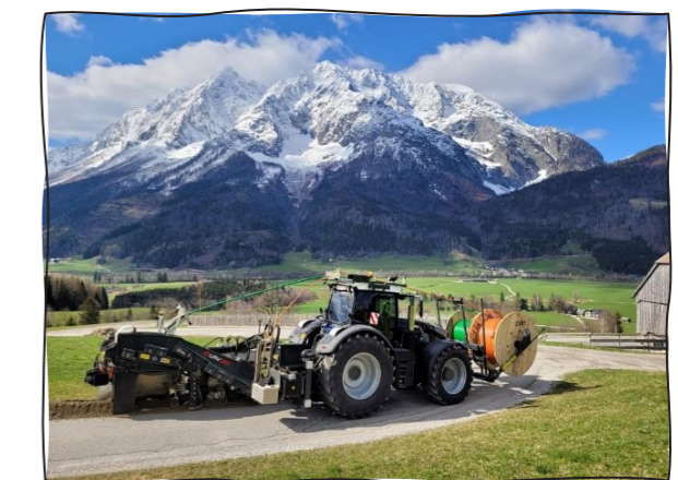
Verlegearbeiten mit dem Layjet © Florian Lämmerer
