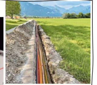
Der Glasfaserausbau im Bezirk läuft auf Hochtouren. (RADAR)
